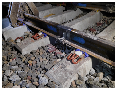
FIGURE 1.4 – Soudure aluminothermique d'un rail (Image libre de droit. Source : Wikimedia Commons)
