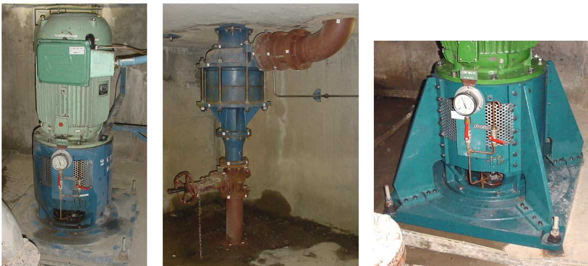
FIG. 5.12 – Photos du moteur (à gauche), de la pompe située à l'étage inférieur (au milieu), et de l'embase modifiée (à droite)
